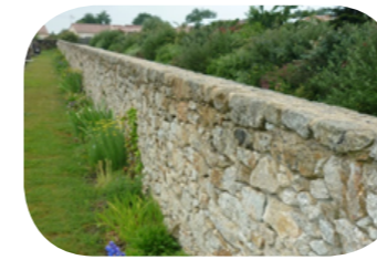
Travaux réalisés sur 3 ans depuis 2015 | Beaurepaire
