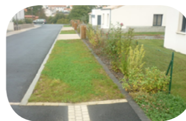
Trottoir enherbé - noue filtrante | La Tessoualle (79)
