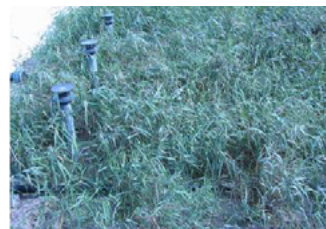
Filtre planté de roseaux (10%)
